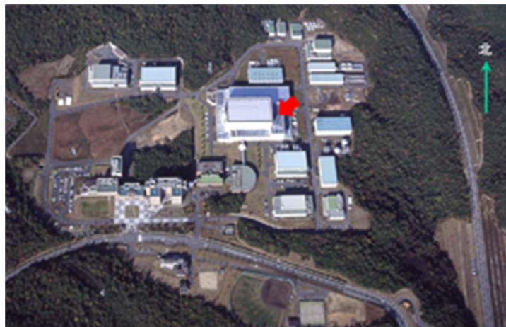
図 1 核融合科学研究所の全景。矢印で示されている大型ヘリカル実験棟ヘリウム液化冷凍機室で火災が発生しました。
